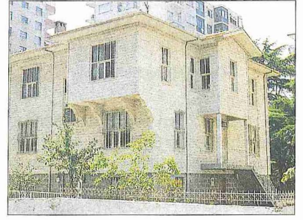
Esad Erbilî'nin restore edilen köşkü - Kozyatağı / İstanbul
