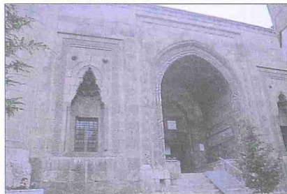
Gökmedrese Camii'nin kuzey (giriş) cephesi
