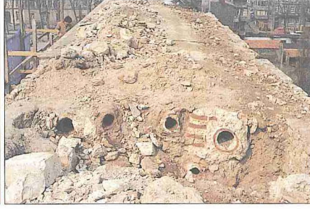
Beylik ve Süleymaniye su yolları üzerinde bulunan Ali Paşa Kemer'i ile Bozdoğan Kemer'i üzerindeki su künkleri
