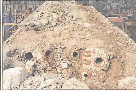
Beylik ve Süleymaniye su yolları üzerinde bulunan Ali Paşa Kemerli ile Bozdoğan Kemerli üzerindeki su künkleri
