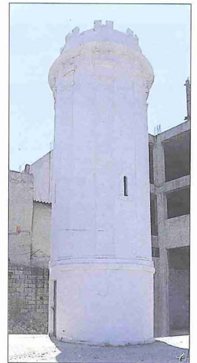
Hamidiye suyu tesislerine ait su deposu 4. Levent / İstanbul
