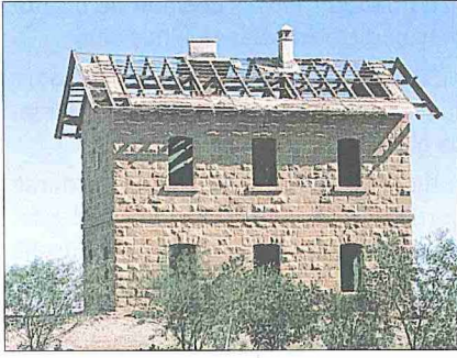
Hicaz demiryolu üzerinde bulunan Tebük İstasyonu
