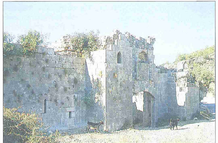
Alara Hanı'nın cepheden görünüşü
