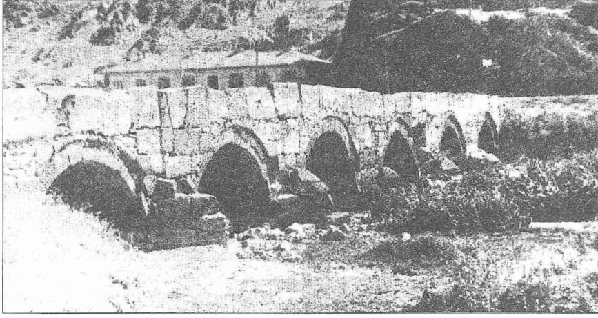
Altıgöz Köprüsü - Afyonkarahisar
