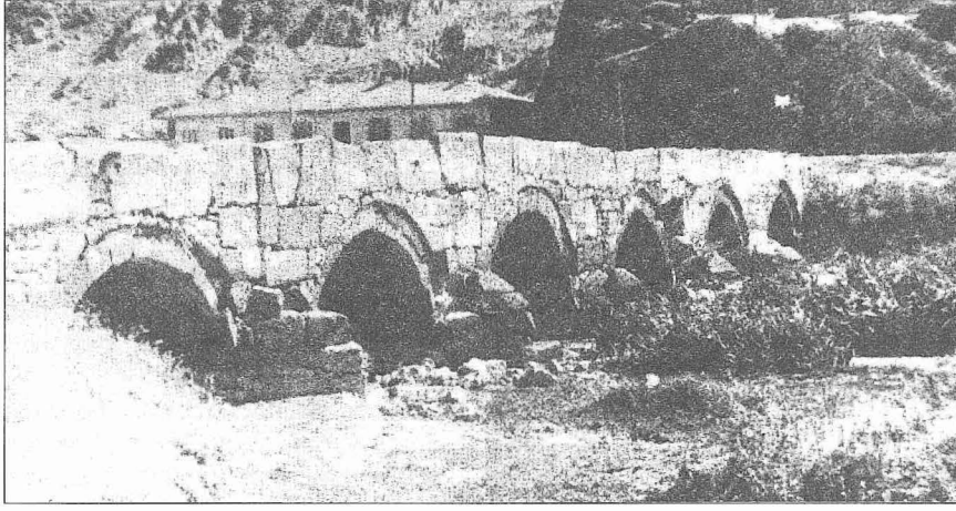
Altıgöz Köprüsü - Afyonkarahisar
