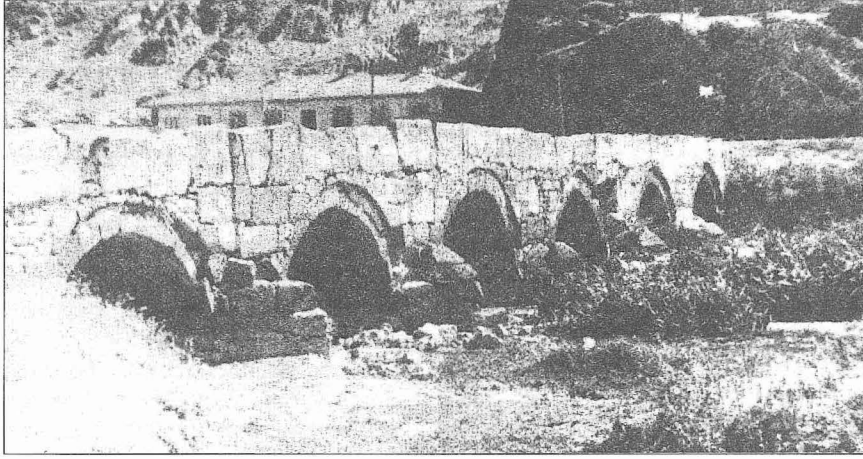
Altıgöz Köprüsü - Afyonkarahisar
