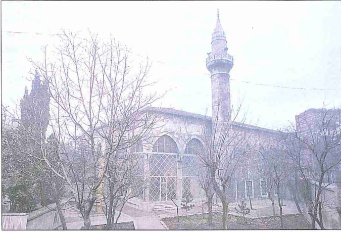
İbrâhim Paşa Camii – Eminönü / İstanbul
