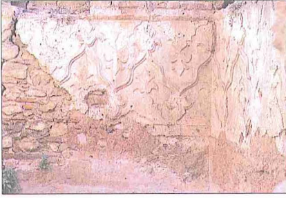
İsmâil Bey Hamamı'nın duvarlarındaki alçı süsleme
