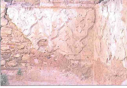
İsmâil Bey Hamamı'nın duvarlarındaki alçı süsleme
