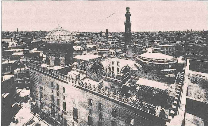
Kalavun Külliyesi'nin bîmâristan kısmı
