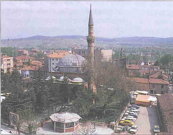
Kasım Paşa Külliyesi ve külliyeinin imaretinden bir görünüş
