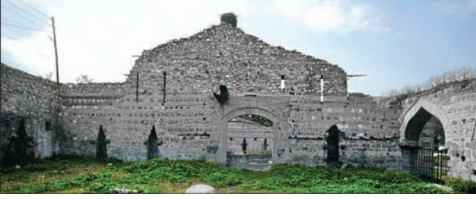
XVII. yüzyılın ortalarında inşa edilen Köprülü Mehmed Paşa Kervansarayı – Vezirhan / Bilecik
