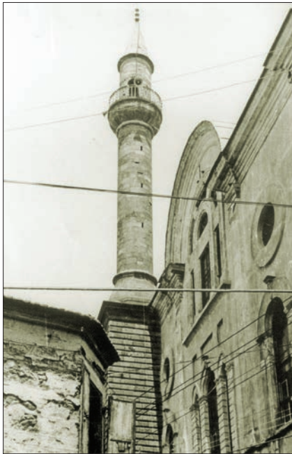
Kestanepazarı Camii'nin minaresiyle batı cephesinden bir görünüşü
