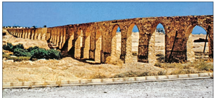
Larnaka - Limasol yolu üzerindeki Ebûbekir Paşa su kemerleri
