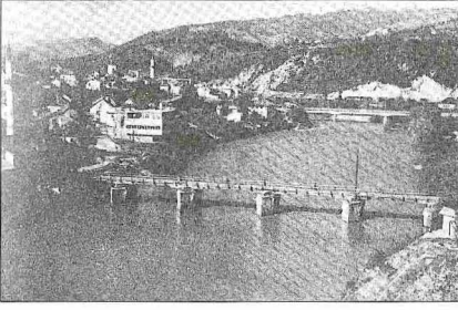
Konice Neretva Köprüsü'nün yıkırdıktan sonraki hali
