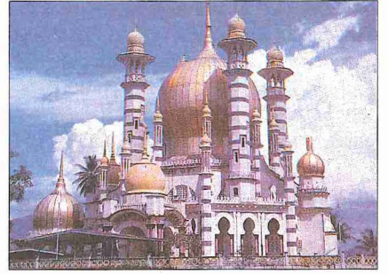
Hint mimarisi üslûbunda inşa edilen Ubûdiye Camii - Kuala Lumpur / Malezya
