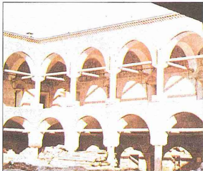
Kurşunlu Han'ın avlu revaklarından bir görünüş
