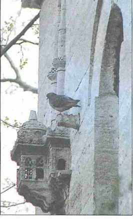
Istanbul Üsküdar Yeni Vâlide Camii'nin kuşevleri
