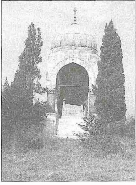
Mahmut Şevket Paşa'nın Hüriyet Tepesi'ndeki türbesi - İstanbul
