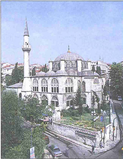
Mesih Paşa Camii – Fatih / İstanbul
