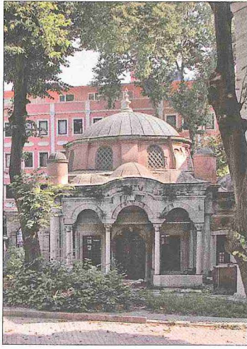
Nuruosmaniye Camii hünkâr mahfiliye Şehsuvar Vâlide Sultan Türbesi
