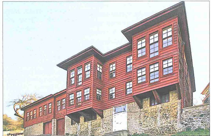
Sultantepe'de Özbekler Tekkesi (restorasyondan sonra)
