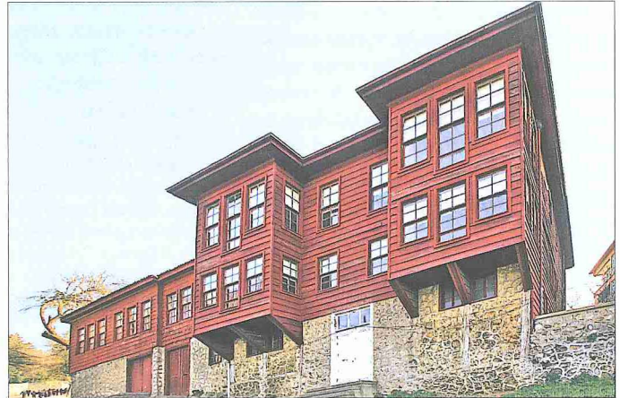
Sultantepe'de Özbekler Tekkesi (restorasyondan sonra)
