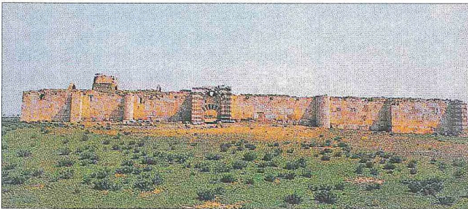
Konya-Aksaray yolu üzerinde Tömek köyü yakınındaki Sâdeddin Köpek Hanı (Zazâdin Hanı)
