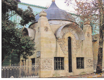
Şeyh Zâfir Türbesi -Beşiktaş /İstanbul
