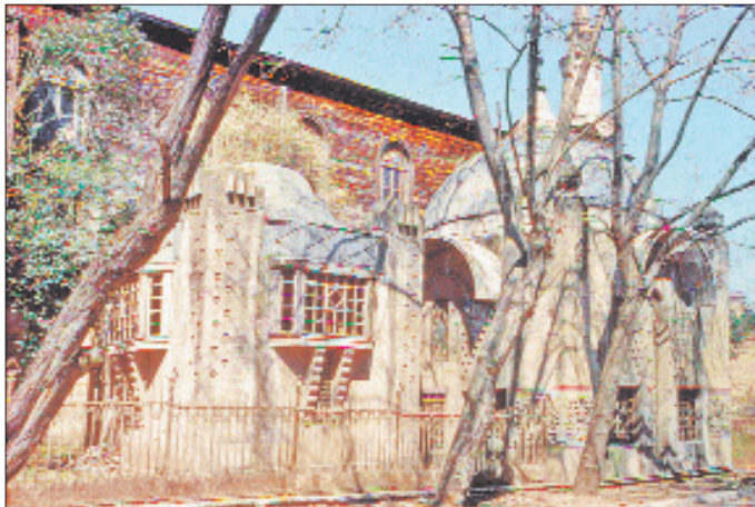
Şeyh Zâfir Türbesi ve Kütüphanesi – Beşiktaş / İstanbul
