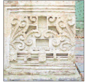
Şeyh Zâfir Türbesi'nin dış cephesinden bir taş süsleme detayı
