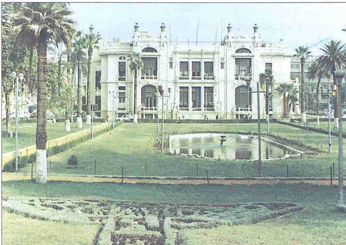
Aynişems Üniversitesi rektörlük binası - Mısır
