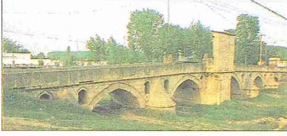
Babaeski Köprüsü ve köprünün inşa kitâbesi- Kırklareli
