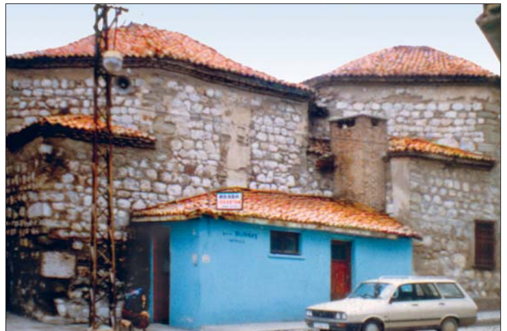
Temerrüd Ali Paşa tarafından Çorum'da inşa ettirilen hamam
