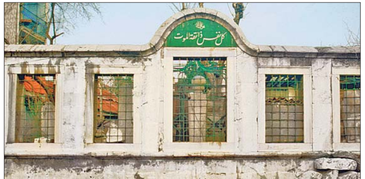
Üsküdar Rifâi Âsitânesi'nden günümüze ulaşan pencereli çevre duvarı
