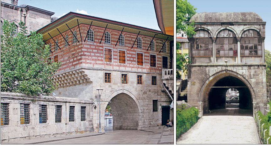
Eminönü'nde Yenıcamı Hünkâr Kasrı'nı ve Hekimoğlu Ali Paşa Kütüphanesi'ni taşıyan tonozlar
