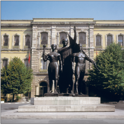
İstanbul Üniversitesi'nin ana kapısı ve merkez binası
