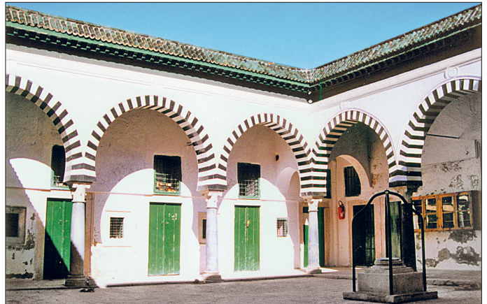
Tunus'ta Bâşiyye Medresesi'nin revaklı avlusu
