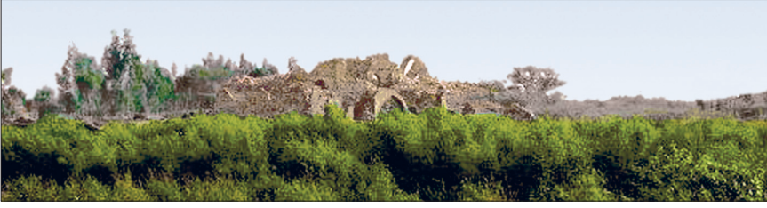
Ukâz'da bir yapı harabesi
