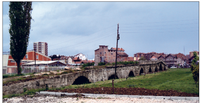
Vulçitrin'da Osmanlı taş köprüsü
