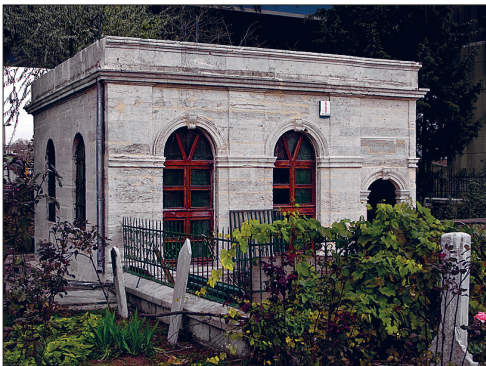
Yâvedüd Türbesi ve Çeşmesi - Eyüp / İstanbul
