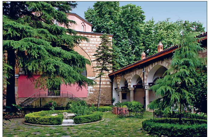
Yeşilcamı Külliyesi'nin medrese avlusundan bir görünüş
