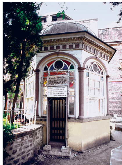
Zağanos Paşa Türbesi – Balıkesir
