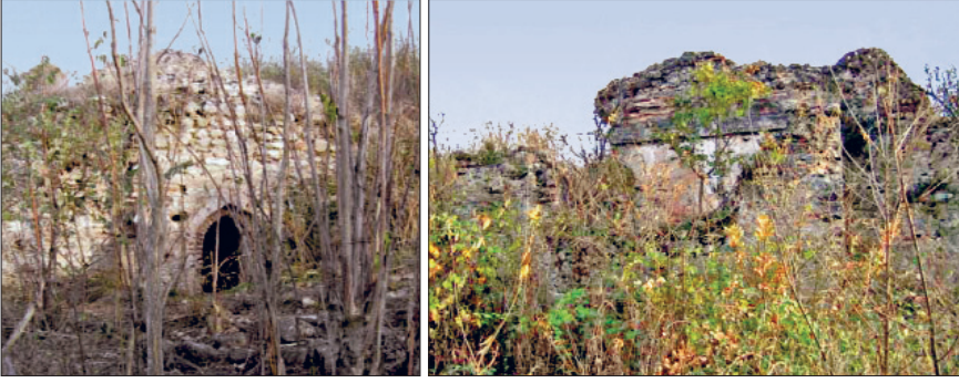
XV. yüzyıl Osmanlı hamamının dış görünüşü ve II. Bayezid döneminde tahminen 1490 yılında inşa edilen Eski Camii'nin kalıntıları
