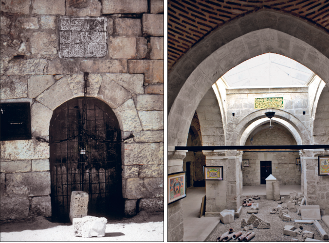
Zincirli Medrese'nin kapısı ve içinden bir görünüş
