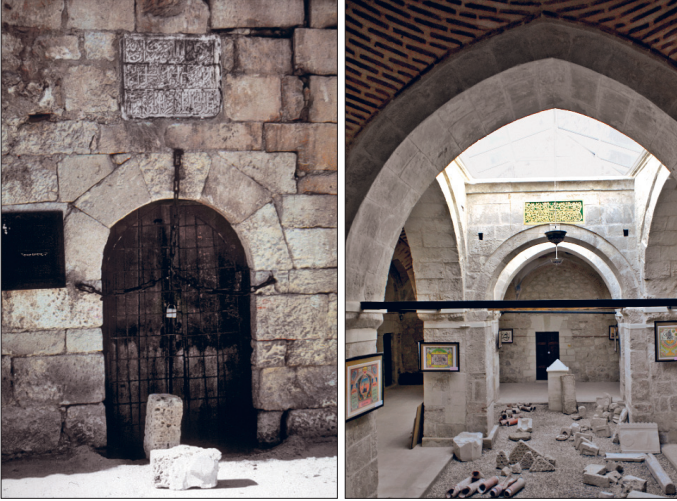
Zincirli Medrese'nin kapısı ve içinden bir görünüş
