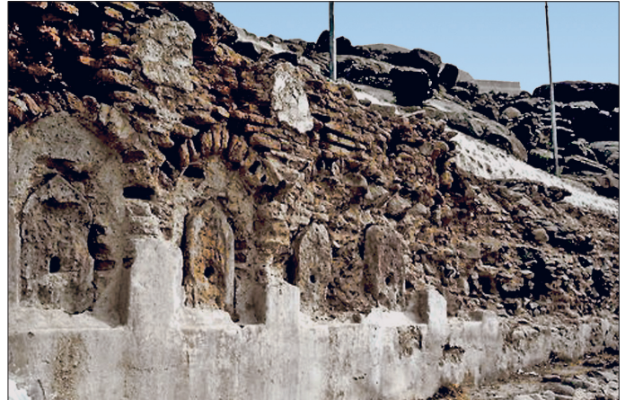
Zübeyde bint Ca'fer'in Hülle-Mekke arasında inşa ettirdiği su kanallarına ait kalıntı
