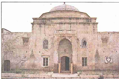
Bâlî Bey Camii - Yenişehir / Bursa
