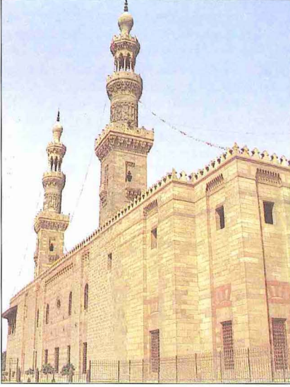
Berkuk Camii'nin giriş cephesi
