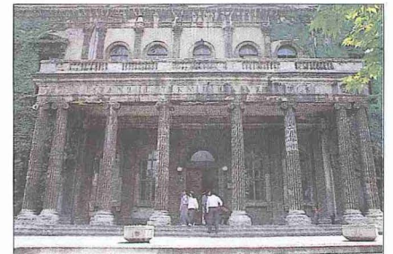
Taşkışla'nın giriş cephesindeki Batı üslûbunda sütunlu çıkma - Gümüşsuyu / İstanbul
