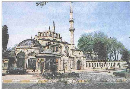
Selâtin camii geleneğine bağlı olarak geçiş dönemi içinde inşa edilen Yeni Vâlide Camii - Üsküdar / İstanbul
