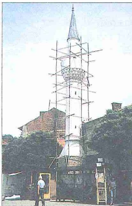
Cum‘a-i Bâlâ’da ayakta kalan tek caminin (XIX. yüzyıla ait) onarımı sırasında görünüüşü (1992)
